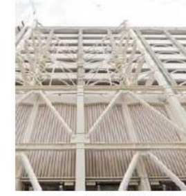
マンション耐震補強工事 (ビルリニューアル)
